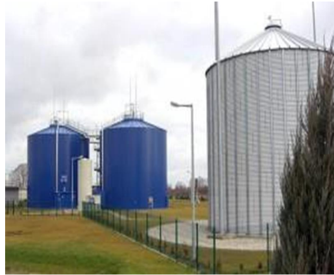
Біогазова електростанція в Івано-Франківській області, 1 МВт
